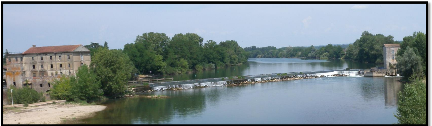
Barrage d'Aiguillon (Dargent, F 2014)
