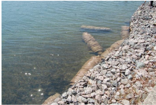
Figure 9 : Les rouleaux de toile de jute sont immergés afin qu'ils se gorgent d'eau (Source : ABV des 7)
