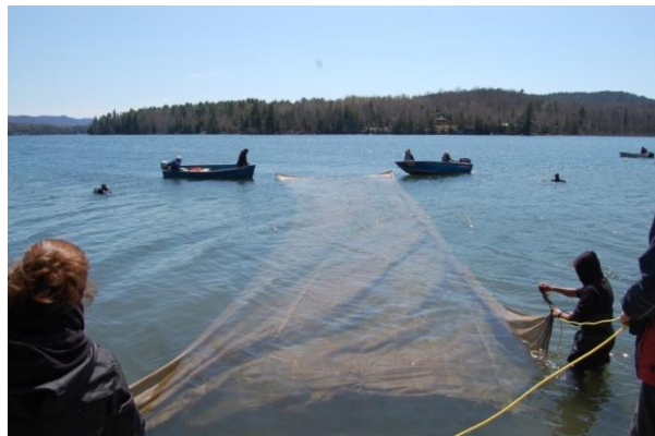
Figure 10 : Deux bateaux déploient la toile de jute, retenue depuis la berge à l'aide de cordes (Source : ABV des 7)
