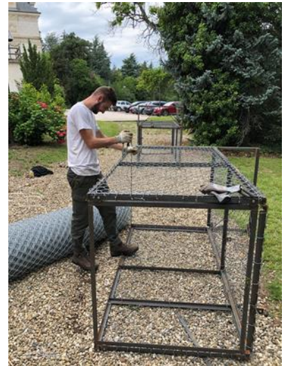
Figure 3. Construction de cages pièges
