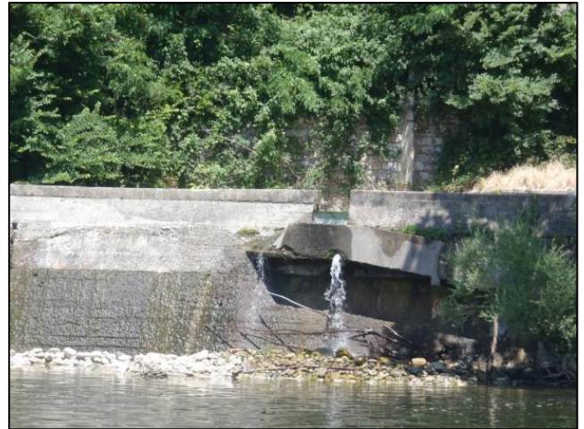
Figure 12 : Fissure dans une passe
