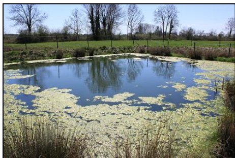
Figure 3 : Bassin de rétention d'Equi-Marault Source : M. Monamicq, 2013
