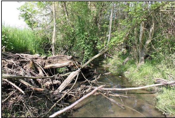
Figure 14 : Troncs tombés sur la berge du fossé Source : M. Monamicq, 2013
