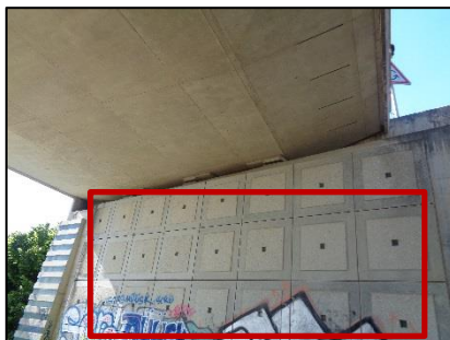
Figure 10. Parements sur un pont de type (1) (CAPITANIO, 2018)
