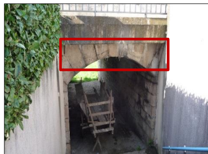
Figure 14. Anfractuosité sur le tympan d'un pont de type (6) (CAPITANIO, 2018)
