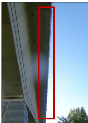
Figure 7. Joint de corniche sur un pont de type (5) (CAPITANIO, 2018)
