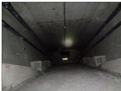
Figure 8. Intérieur d'un voussoir dans un pont de type (5) (CAPITANIO, 2018)
