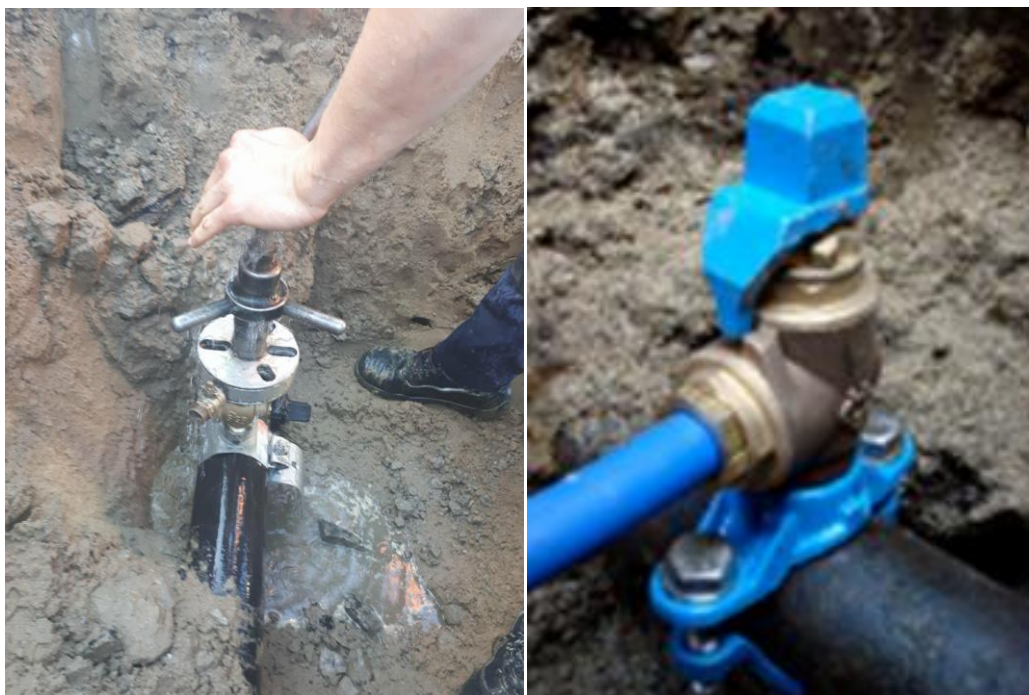
Installation du robinet sur la conduite principale
