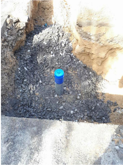
Remblaye avec des cailloux
