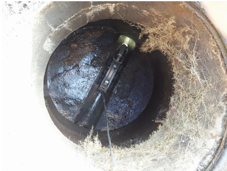
Mise en place de la caméra
