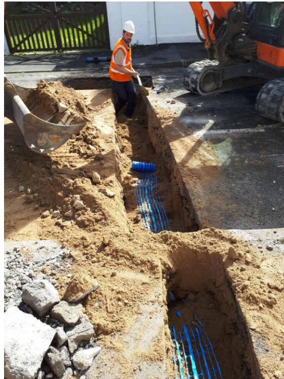
Pose de la signalisation
