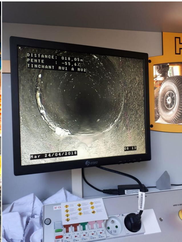
Vue de la canalisation grâce à la caméra
