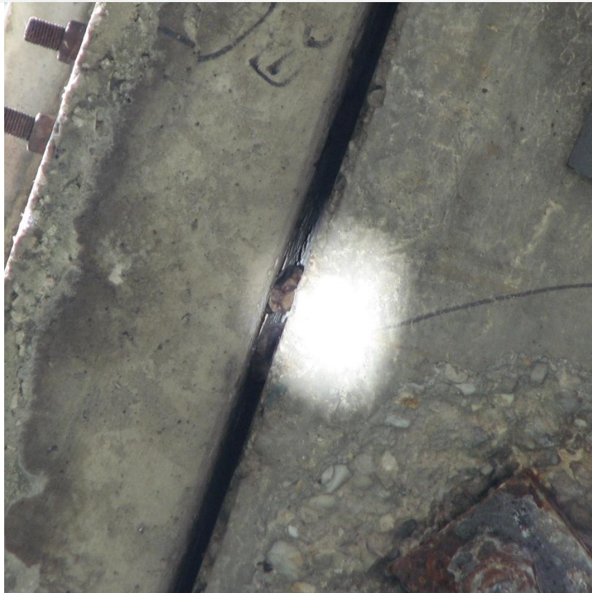
Pipistrelle (non déterminée) sous les jupes du pont Daladier en Avignon
