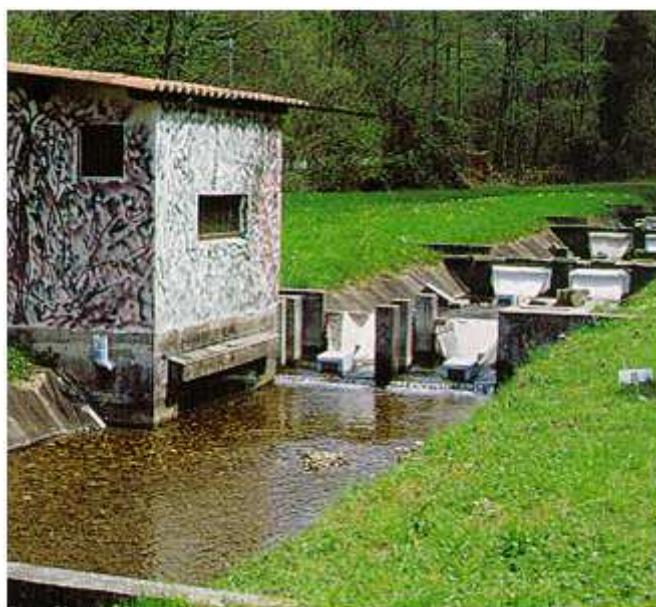
Figure 5. Photographie de la rivière artificielle, alimentée par le Lapitxuri, divisée en biefs dans lesquels l'expérience à été réalisées. (crédit Stephane Glise).
