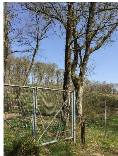
Figure 14: Coupe et barrière infranchissable point 51 à Saint Martin de Hinx (©OP)
