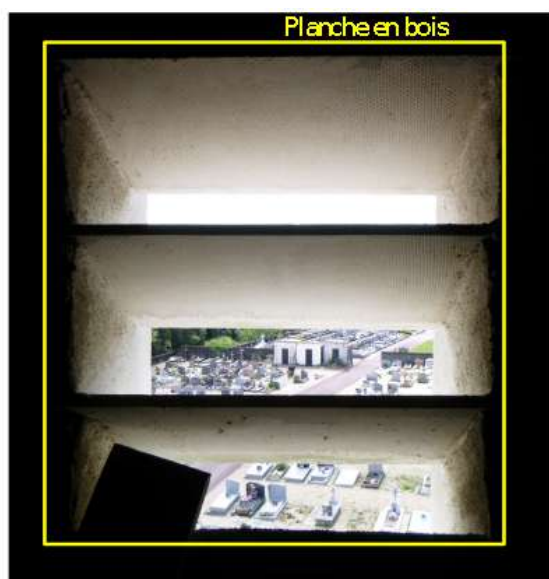
Illustration 11: Schéma de persienne à condamner à gauche et schéma de la persienne à fermer en laissant une fente à droite
