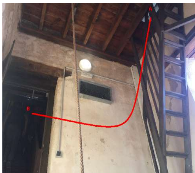
Illustration 16: Passage des chiroptères du clocher (A) aux combles (B)
