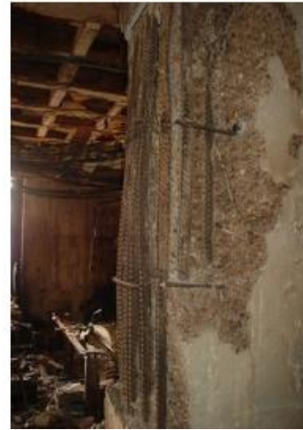
Figure 6. Photo de l'éclatement d'un tablier de pont en Suède suite à l'incendie d'un camion citerne (à gauche) et éclatement d'un poteau de la tour Windsor à Madrid suite à un incendie de 2005 (à droite) (photo : [Bostrom et Lindqvist, 2006])
