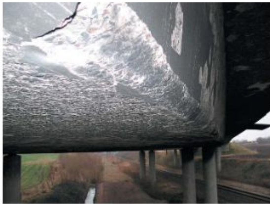
Figure 6. Photo de l'éclatement d'un tablier de pont en Suède suite à l'incendie d'un camion citerne (à gauche) et éclatement d'un poteau de la tour Windsor à Madrid suite à un incendie de 2005 (à droite) (photo : [Bostrom et Lindqvist, 2006])
