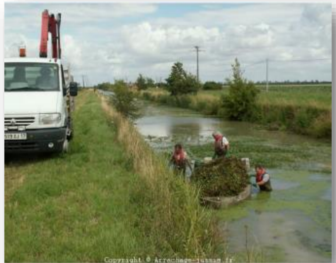
Figure 15: arrachage manuel jussie, bras hydraulique sur plateau pour extraction des déchets verts à partir des berges, entreprise FOUGERE
