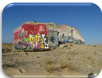
Figure 4. Blockhaus situé au Cap ferret
