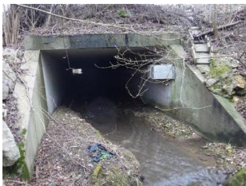
Figure 21 : Ponceau sous l'autoroute A48
