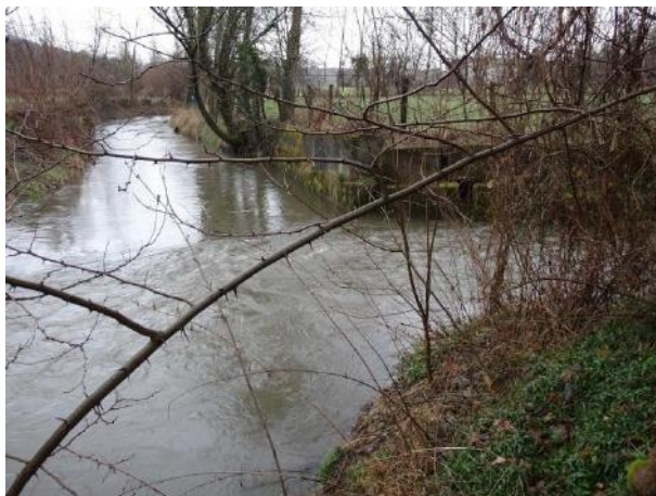
Figure 15 : Confluence du ruisseau de l'Hien avec la Bourbre
