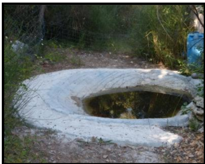
Figure 18 : Photo d'un point d'eau fixe (point d'eau du cabanon).
