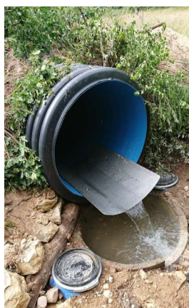
Figure 9 : Vue du seuil passage et de sa buse piège Source : personne
