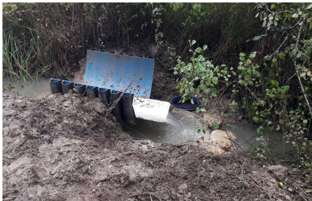
Figure 38 : Deuxième seuil sécurité Source : personnel
