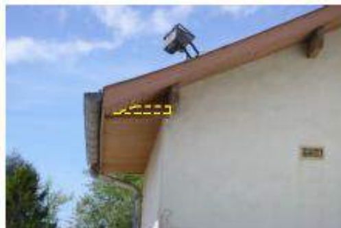
Façade Sud, latte à enlever
