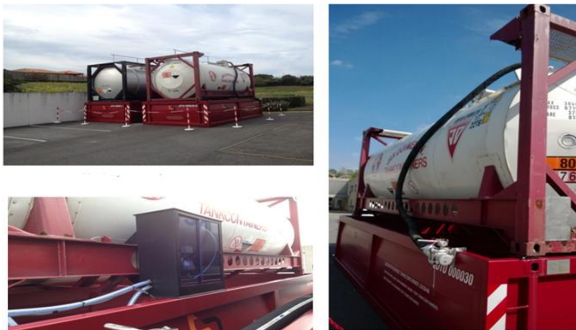
Figure 6 : photographies des cuves (en haut à gauche), des pompes doseuses (en bas à gauche) et du point de dépotage
