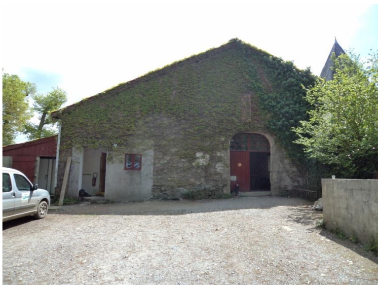
Figure 1 : Structure d'accueil, MIFENEC
