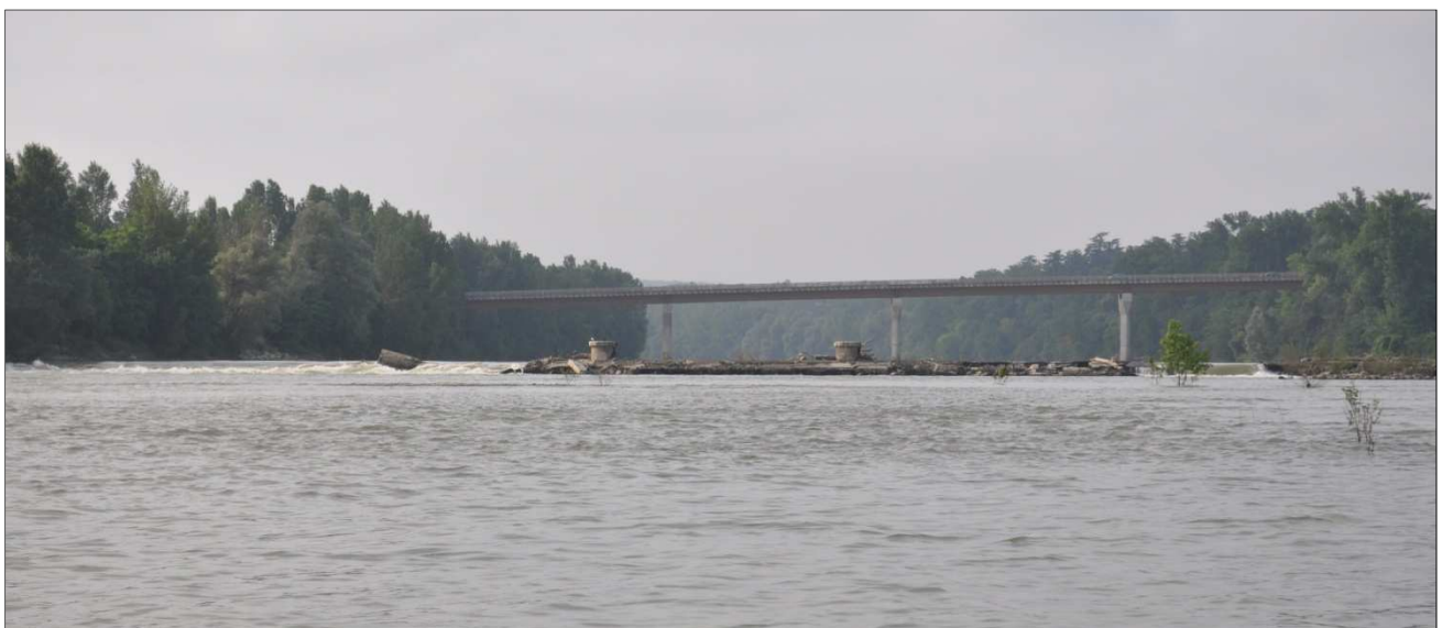
Figure 29 : État actuel du seuil de Beauregard Source : MONEUSE S., 2013
