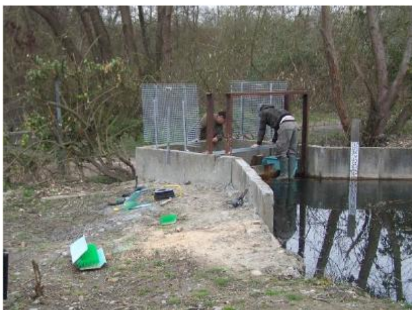
Figure 9 Travaux d'aménagement pour le renforcement du déversoir et l'installation d'une passe à anguilles, 2011-2012
