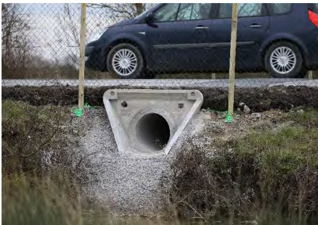
Figure 2. Photo du nouveau passage busé (Source : Antoine Cassel)
