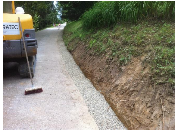
Pose et remblayage des tuyaux
