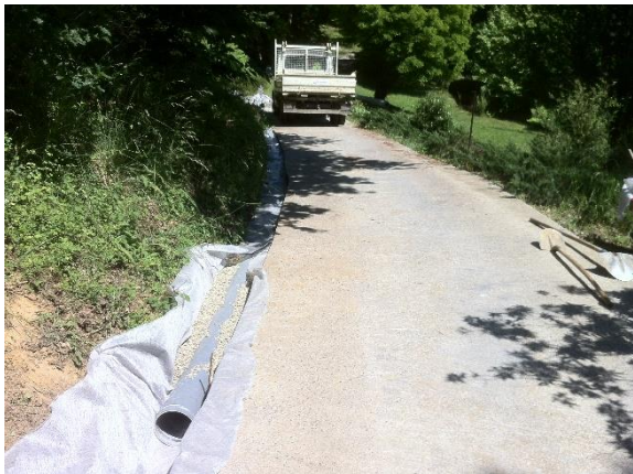
Pose et remblayage des tuyaux
