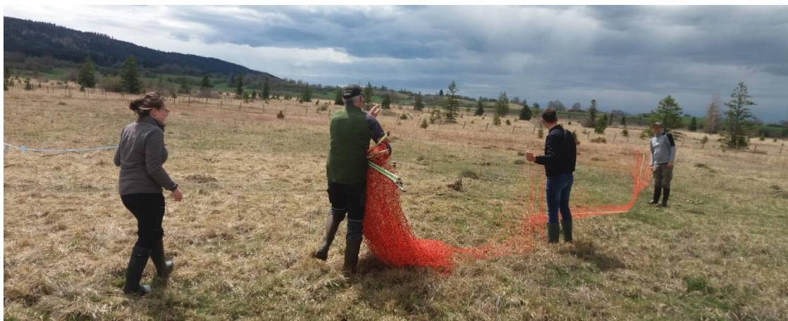
Figure 11 : Installation des filets de protections
