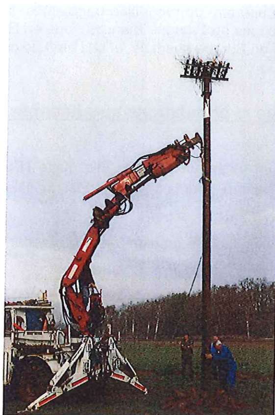
Figure 5 : Installation de plateforme artificielle (photo FDC40)
