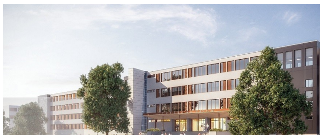
Illustration 1: Image du lycée René Cassin après travaux (d'après l'entreprise Alpes Contrôles)
