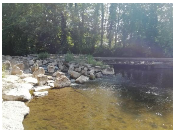
Aménagement sur le seuil de la Ségarie sur la Bave © Personnel
