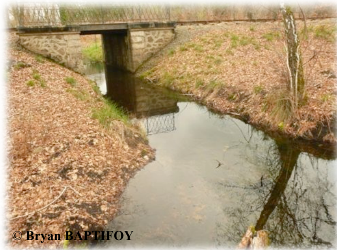
Figure 15 : Pont nord-ouest du marais de Hapchot
